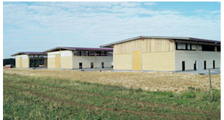
Die neuen Hallen auf dem Betrieb Binkele hat die Dausch Hallen GmbH aus Holz gebaut. So sind sie besonders ökologisch. | Foto: Dausch Hallen GmbH
